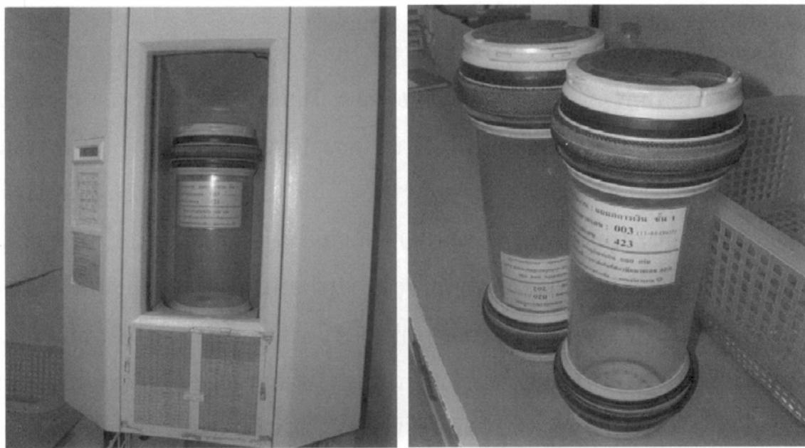
รูปที่ 10 : แสดงระบบส่งอุปกรณ์ สิ่งส่งตรวจ เอกสารต่าง ๆ ทางการแพทย์ โดยระบบสูญญากาศ (vacuum)
